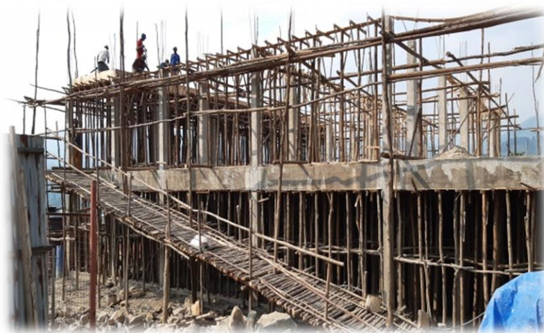
De school in aanbouw
